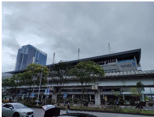
南港展覽館1号館全景
