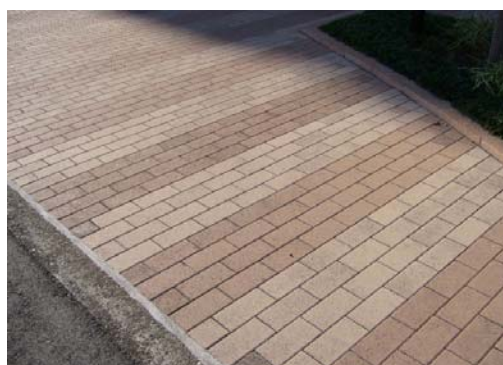
写真9 ⑩歩道 (コンクリートブロック細目)
