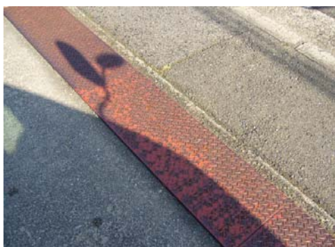
写真10 ⑪側溝の鉄板
